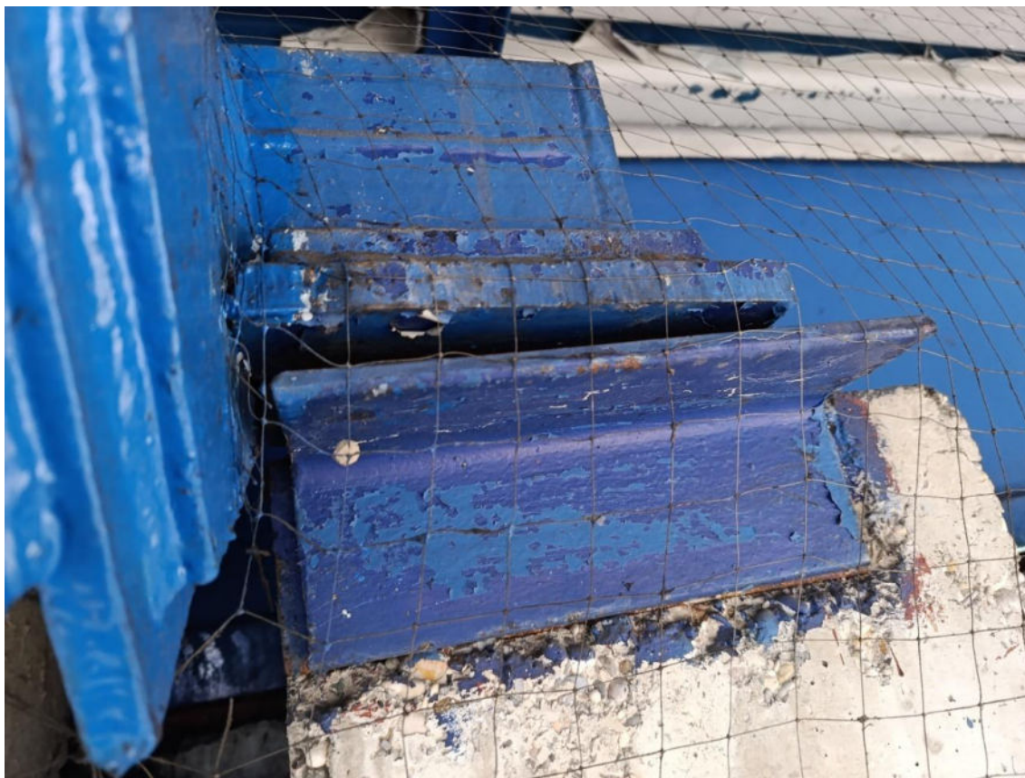
Slika 1 Pomak na spoju čeličnog profila i L profila
