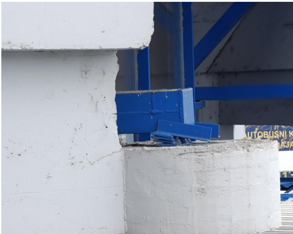
Slika 12 Pomak spoja iz ležaja – pozicija: sjeverno pročelje čekaonice na katu
